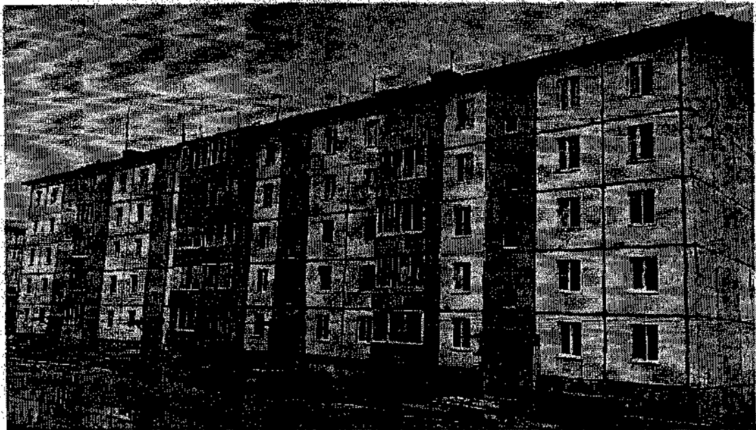
Фото Б2. Дворовой фасад здания.
